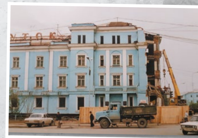
Ремонт аварийного здания, г. Якутск, 1996 год.
